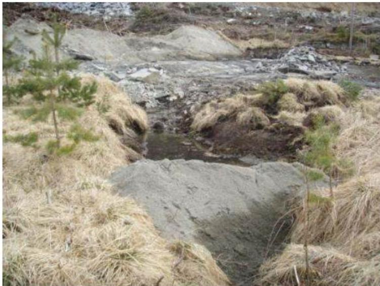
Figur 35. I tillegg til kulefanget bak skiskyttarblinkane vart arealet under blinkane og 6-8 meter tilbake mot skyttar sanert. Bekken er lukka med sandfilter slik at forureining ikkje skal spreiasi i tiltakfasen. Foto Cowi.
