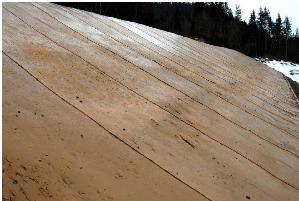
Figur 28. Treffpunkt i gummiduk som dekkjer kulefanget på ei korthaldsbane. Variert bruk av målmateriell og ulike skyteposisjonar gjev stor spreiing av treffpunkt i kulefanget. Foto MB.
